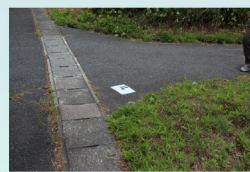
ターゲット設置状況
